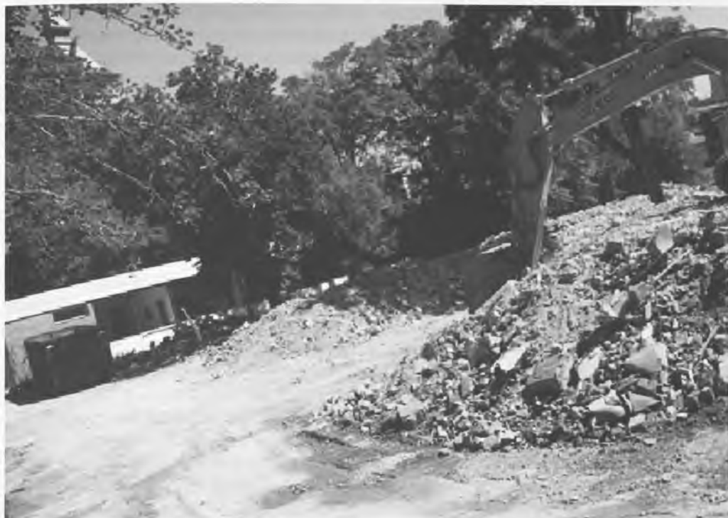
Foto publicada en El Decano de Guadalajara (27 de junio de 2008) de las obras de demolición del antiguo colegio.
