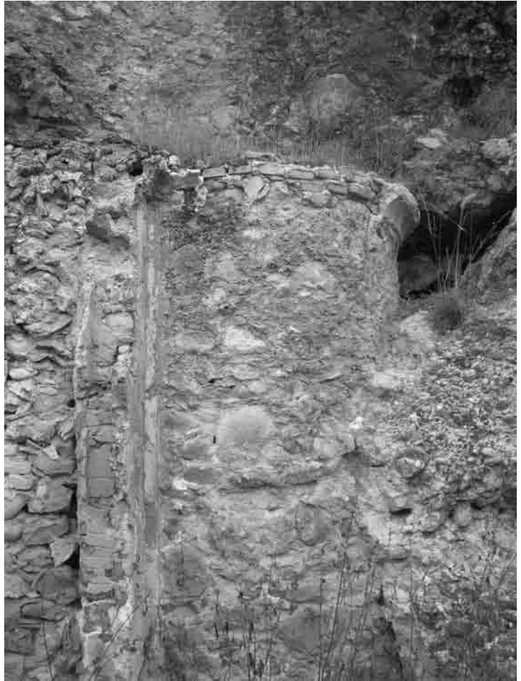
Fotografía 3. Detalle constructivo sobre el muro oeste, con arranque del aparente arco semicircular de cierre.
