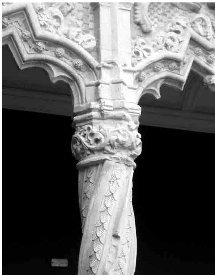
Fotografía 3. Capitel de la arquería superior, patio de honor. Palacio del Infantado.
