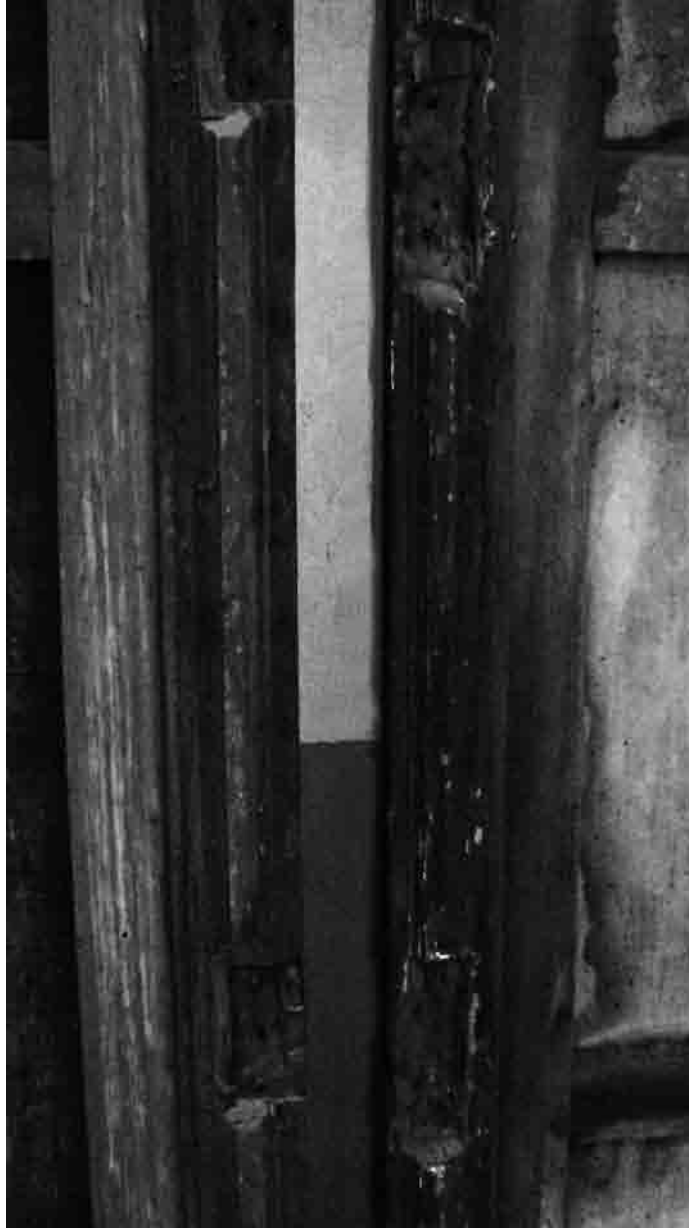
Figura 9. Detalle de las marcas de anclajes de San Bernabé y San Lucas Evangelista .
