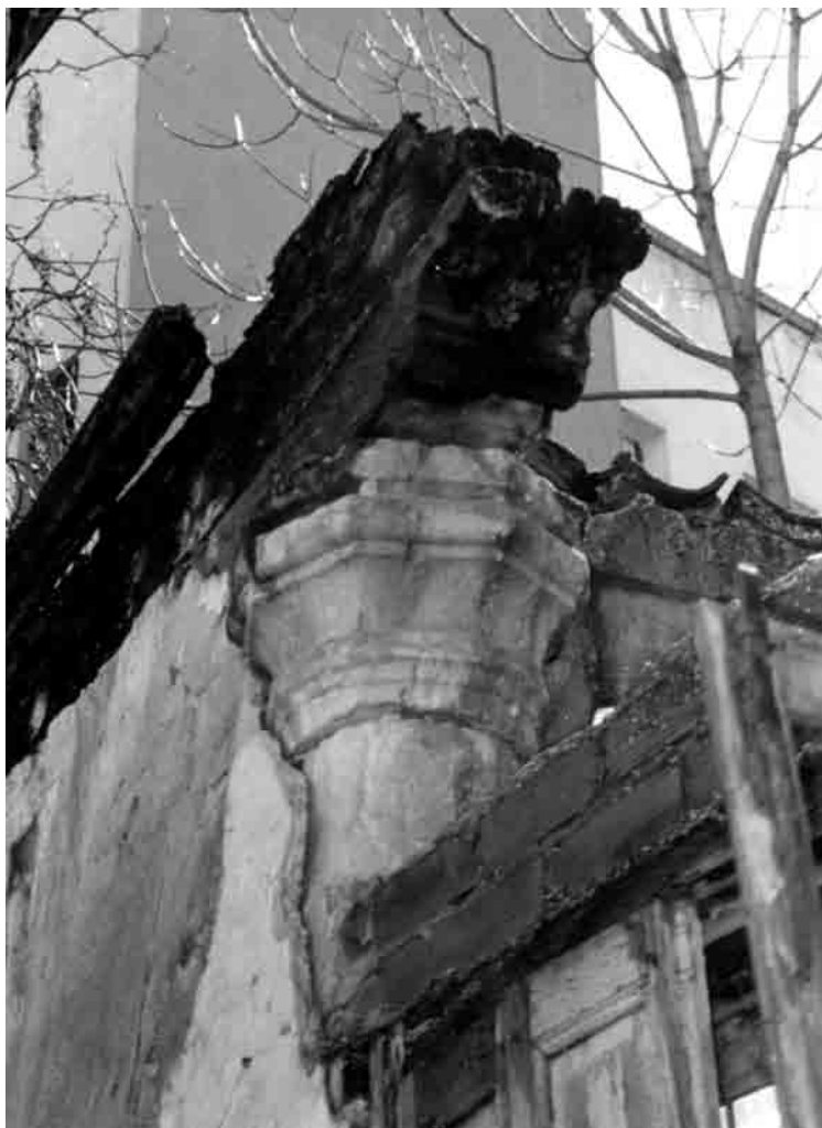
Fotografía 4. Capitel con zapata y jácena de madera, restos patio antiguo, calle Mayor número 13.
