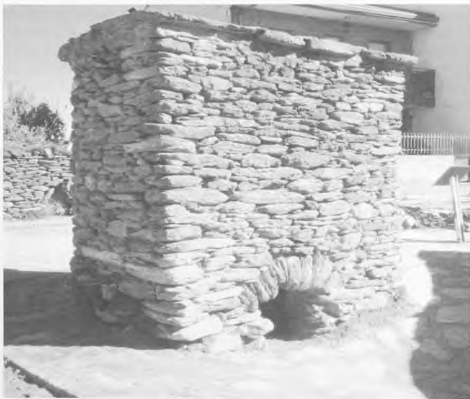
Figura 5. Foto actual del horno alfarero de Zarzuela. Vista frontal del horno en la que se aprecia la abertura por la que era introducida la leña.
